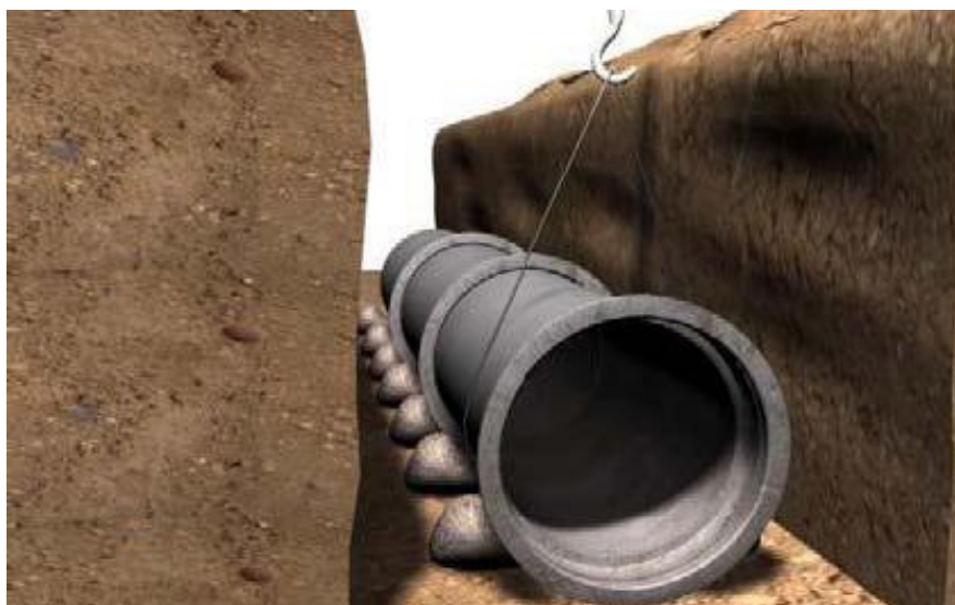
Figura 15 - Alinhamentos dos tubos com apoio de calços
