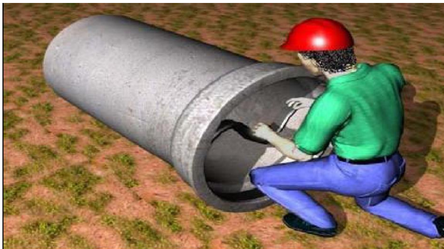
Figura 13 - Colocação do anel de borracha
